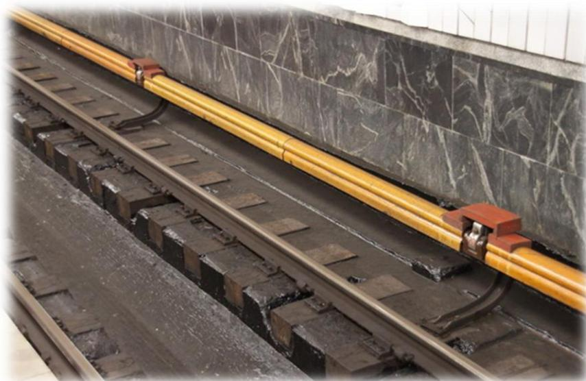
Рис. 8. Контактный рельс
