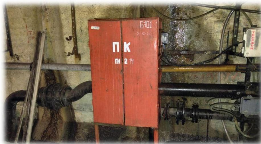
Рис. 31. Пожарный кран в тоннеле
