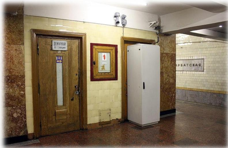
Рис. 29. Пожарный кран в коридоре
