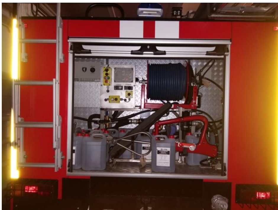
Рисунок 28. Отсек с размещением установки пожаротушения «Кобра»
