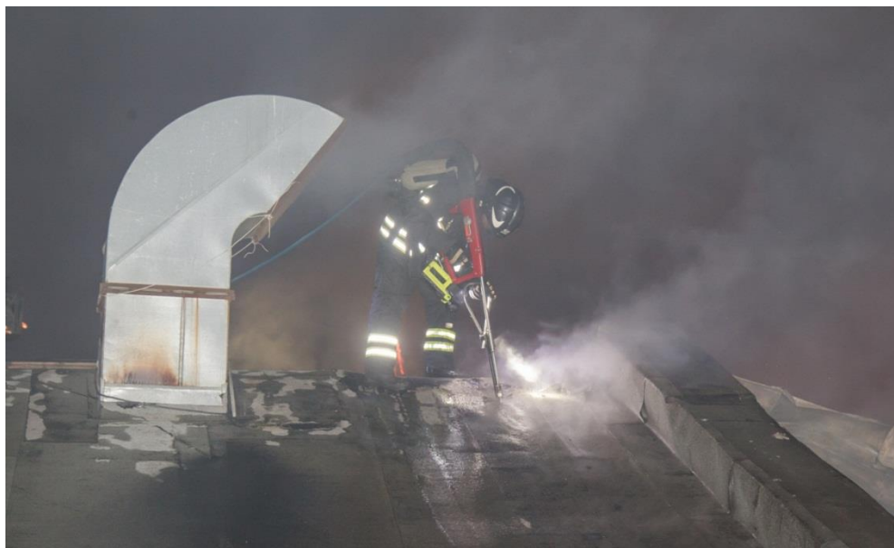
Рисунок 80. Подача ствола установки через кровлю
