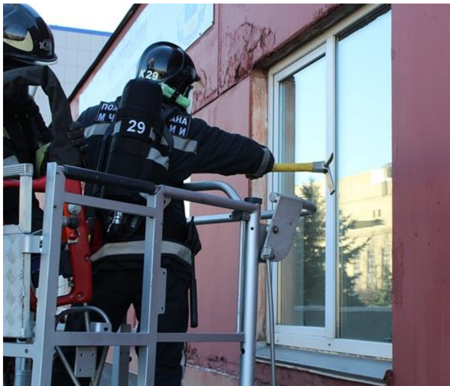
Рисунок 74. Вскрытие оконного проема механизированным способом
