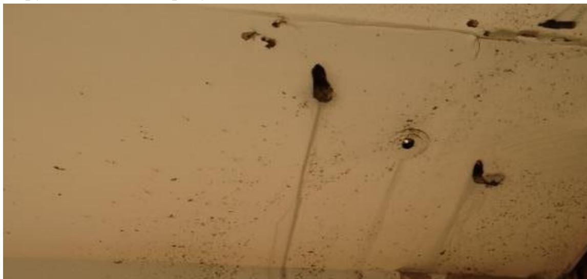
Рисунок 95. Резка конструкции потолка насквозь
