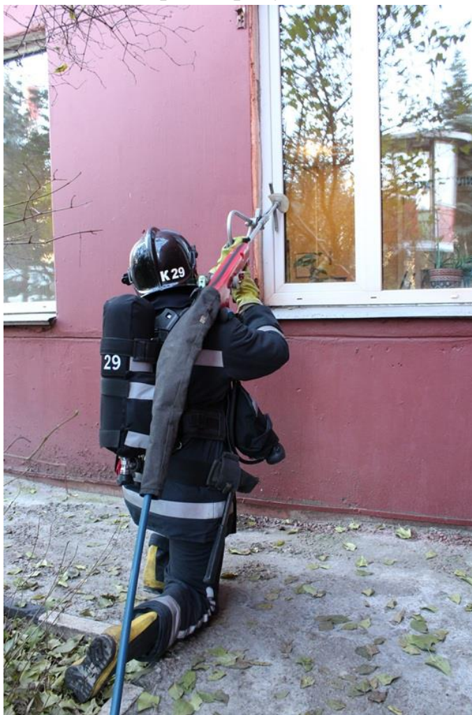
Рисунок 69. Подача ствола установки на тушение через оконный проем
