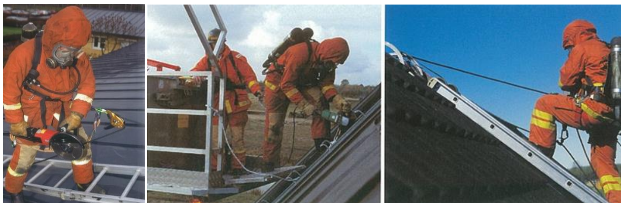
Рисунок 16. Варианты страховки при работе на кровле
