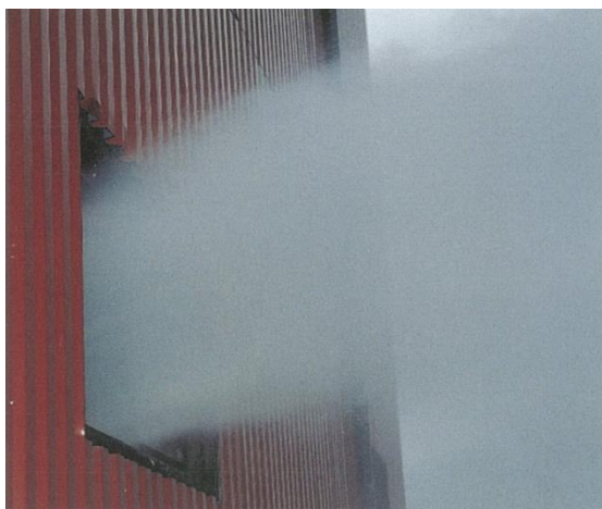
Рисунок 22. Пример гидравлической вентиляции
